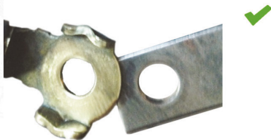
Рис. 2: Подключение заземления после очистки: хороший контакт
